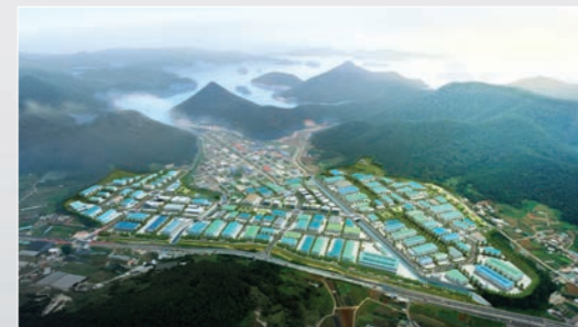
물류단지의 새로운 거점 통영 법송 동원일반산업단지 (시공중 / 기업유치 중 ■문의전화: 055-345-1040)
