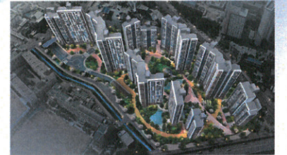
GS건설 대연 자이아파트 신축공사
