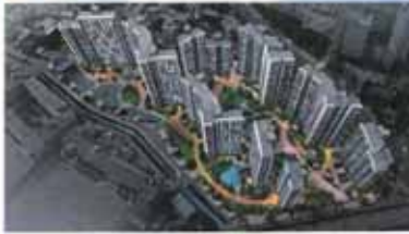
GS건설 대연 자이아파트 신축공사
