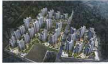
동래 레미안 IPARK 신축공사
