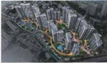
GS건설 대연 자이아파트 신축공사
