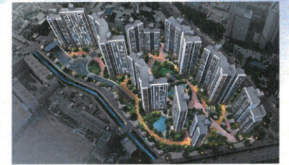
GS건설 대연 자이아파트 신축공사
