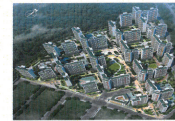
울산 언양 양우내안애 신축공사
