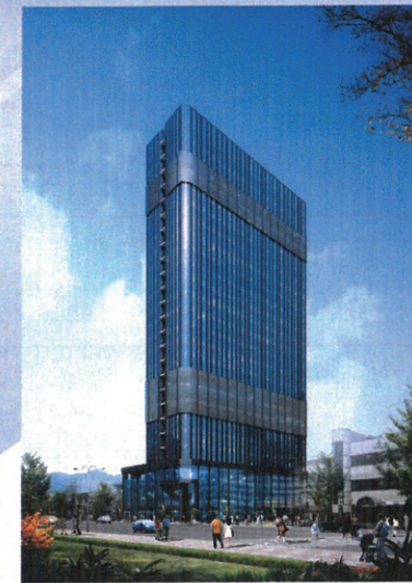
포스코 엔지니어링 신축공사
