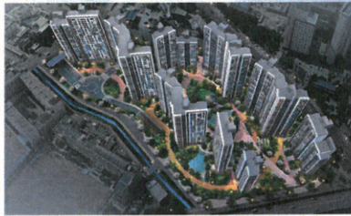
GS건설 대연 자이아파트 신축공사
